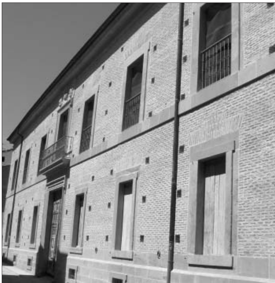
Fachada del Palacio del Gobernador a la Calle de la Rúa, una vez restaurado.
