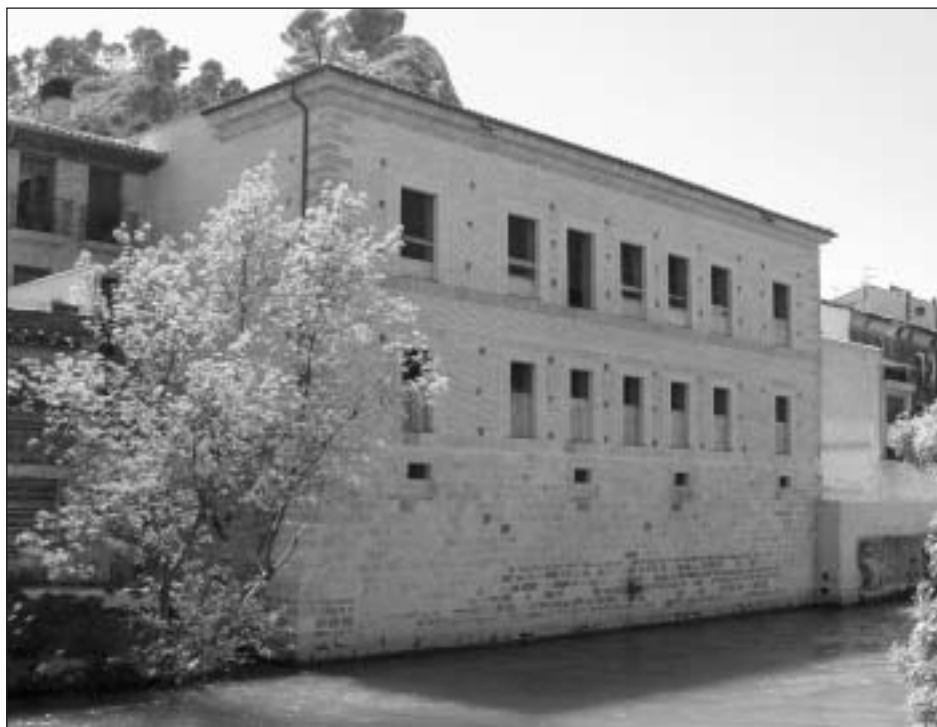
Trasera hacia el río Ega tras su restauración.
