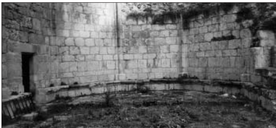
En el lado de la epístola restos del sagrario donde estaba enterrado a sus pies Juan de Elías y Pedro Navascués, en el lado del evangelio capilla funeraria
