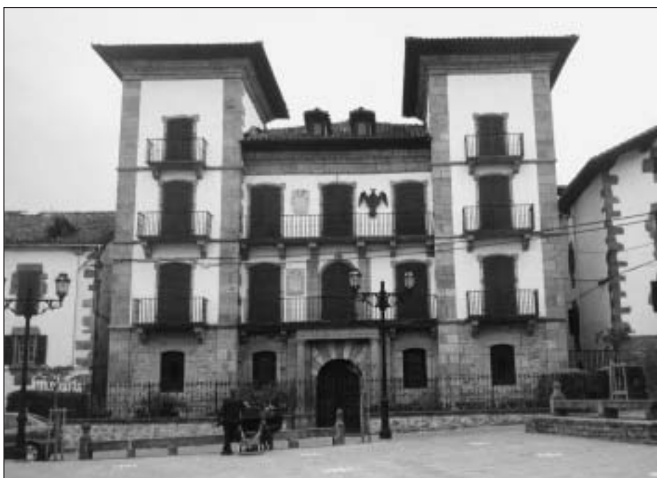
Palacio Gastón de Iriarte en Irurita (Baztán). Fachada principal
