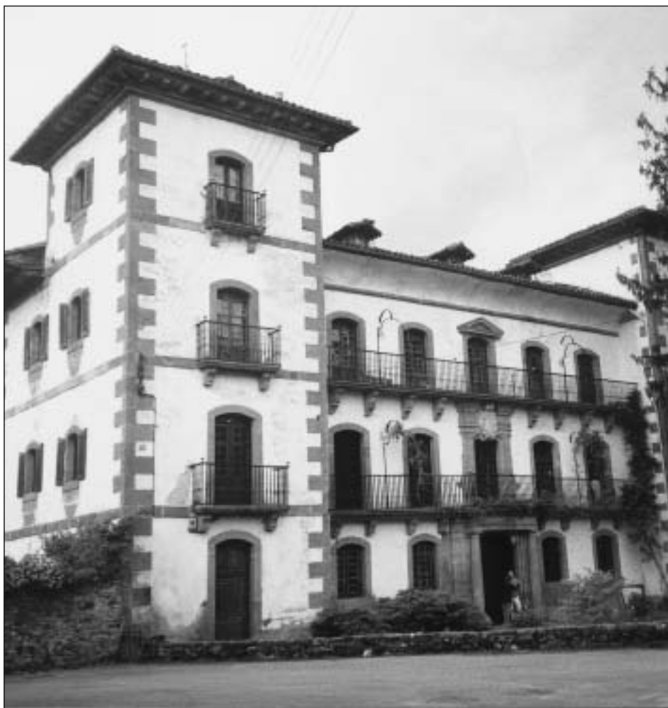
Palacio Reparacea en Oyregui (Bértiz Arana). Fachada principal
