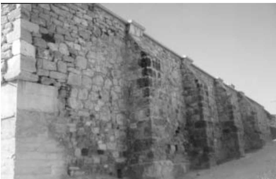
Muro y contrafuertes del palacio de Salinas.
