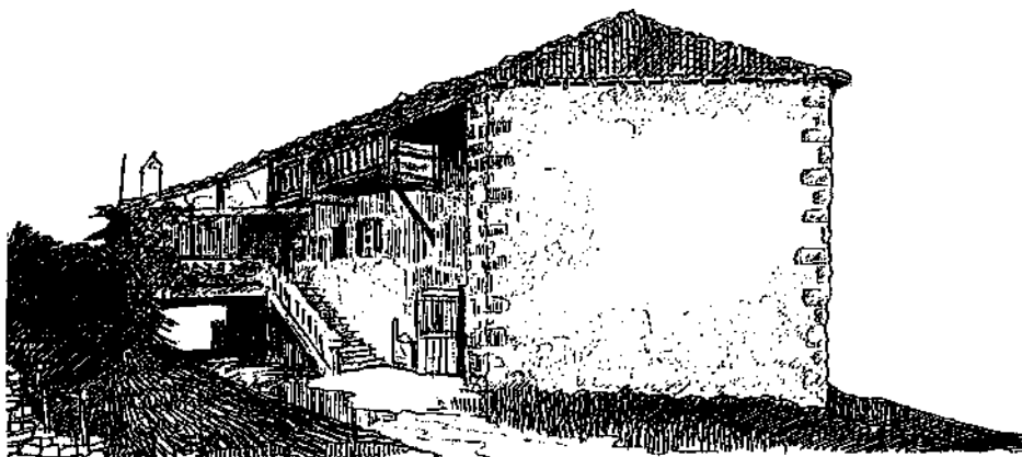
Fig. 6. «Alquebrea» por el norte y oeste.
