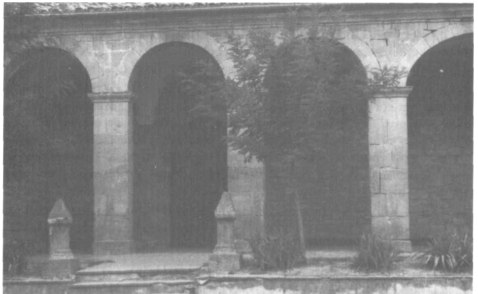
Detalle del Pórtico.
