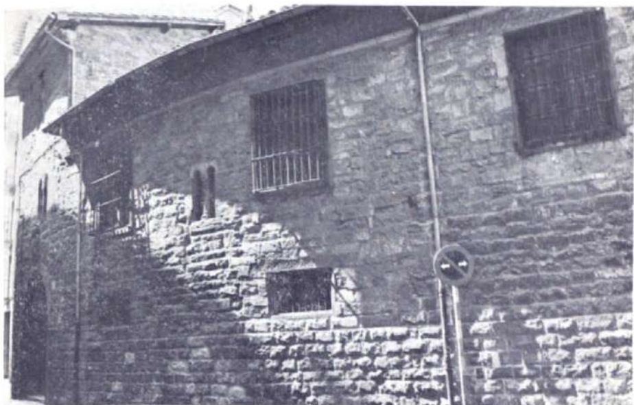
LÁMINA 12 a. Una casa pamplonesa medieval: el palacio del señor de Otazu, en las Tecenderías; después Cámara de Comptos (s. XIII).
