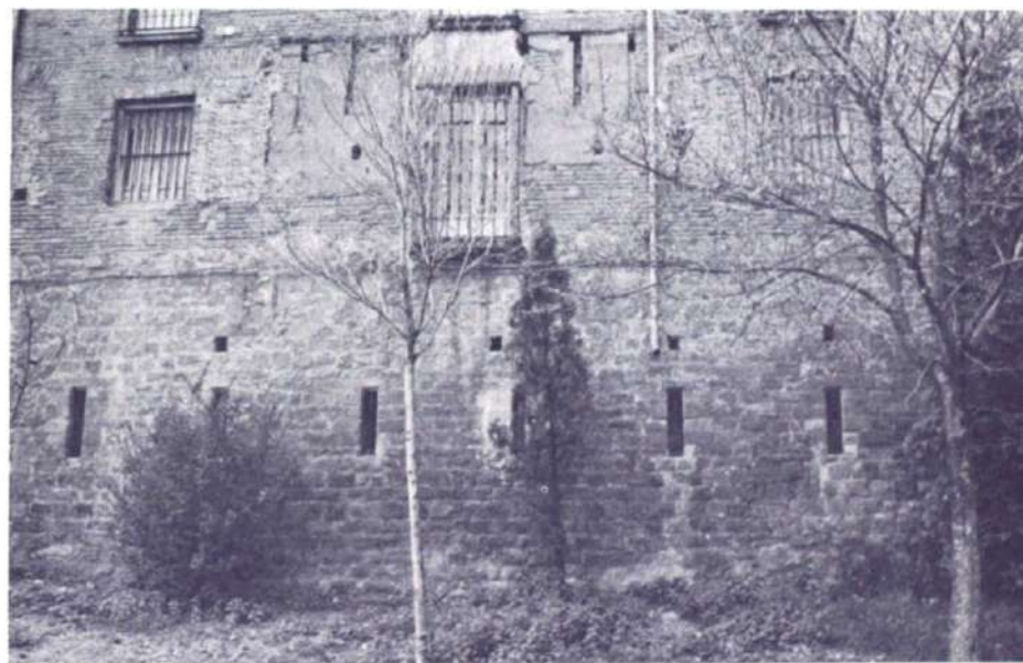
LÁMINA 20 b. Muro aspillerado de la primitiva muralla medieval, junto a la Barbazana (s. XIV?).
