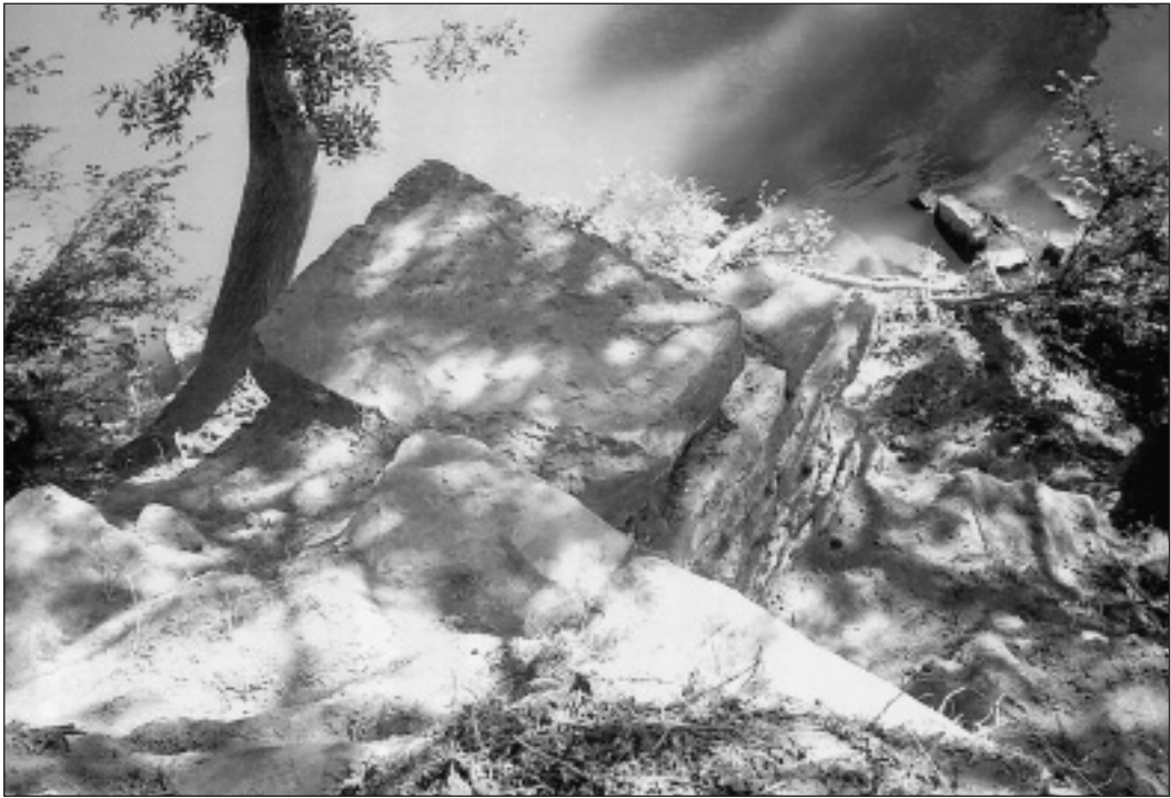
Estribo y zapata. Orilla dercha del río Argá
