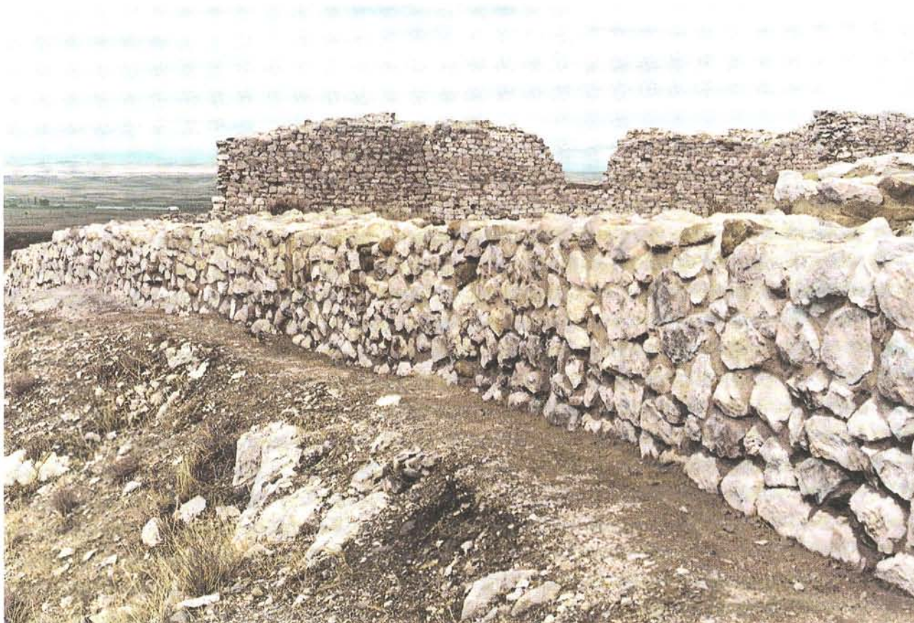
Foto 1 Rada 91. Consolidación de la muralla.
