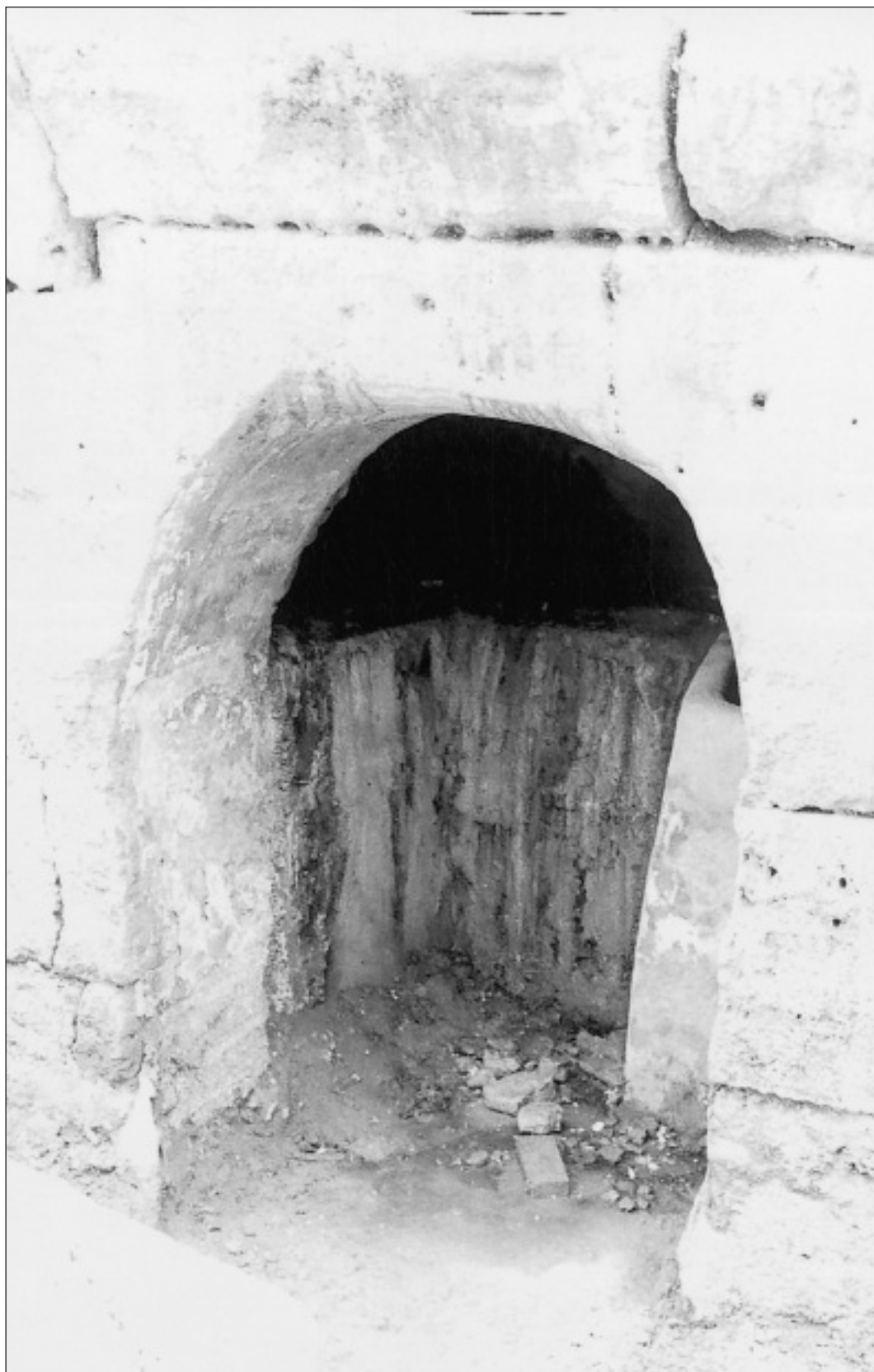
II. Arqueta de captación de agua. Arco de acceso a la galería excavada en la roca
