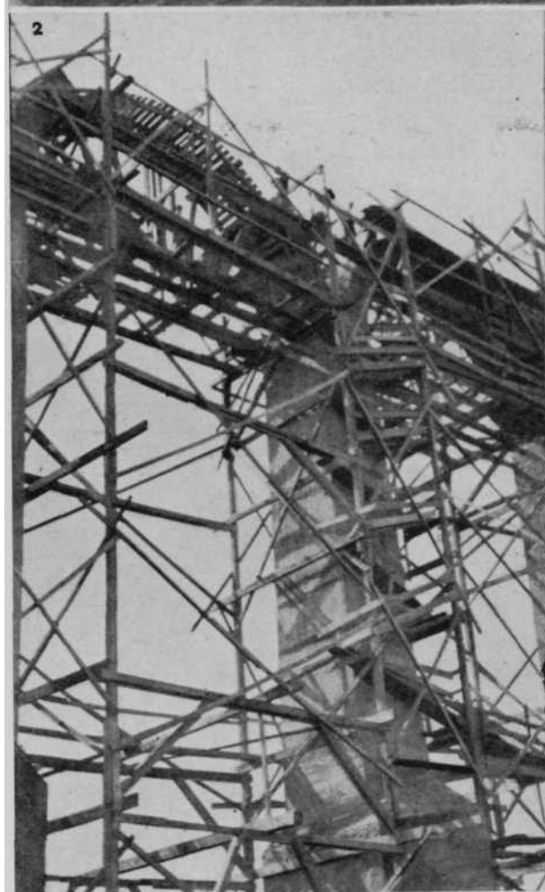
ACUEDUCTO DE NOAIN.—1. Vista de conjunto durante las obras. 2. Encimbrado de los arcos. 3. Terminación de las roscas de los arcos.
