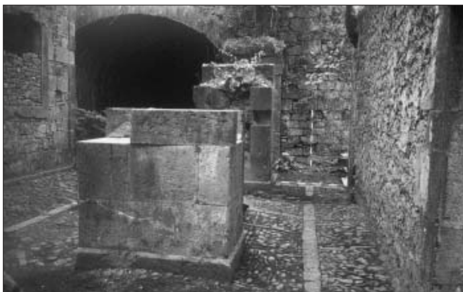
Foto 4. Apoyos del canal y al fondo entrada a las galerías subterráneas
