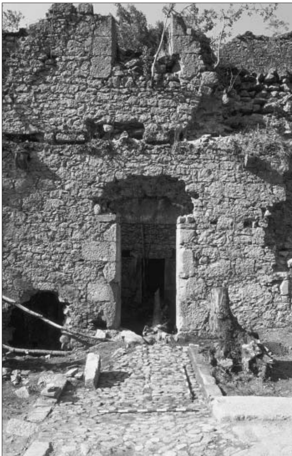
Foto 9. Acceso que comunicaba las dependencias de municiones con la carbonera nº 3
