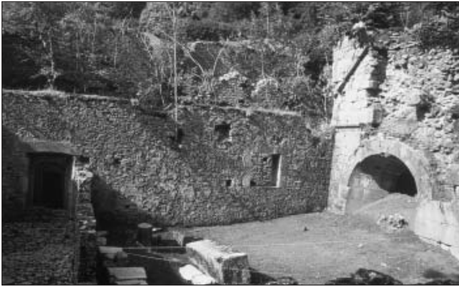
Foto 12. Estructuras remodeladas en el entorno de la oficina de hornos
