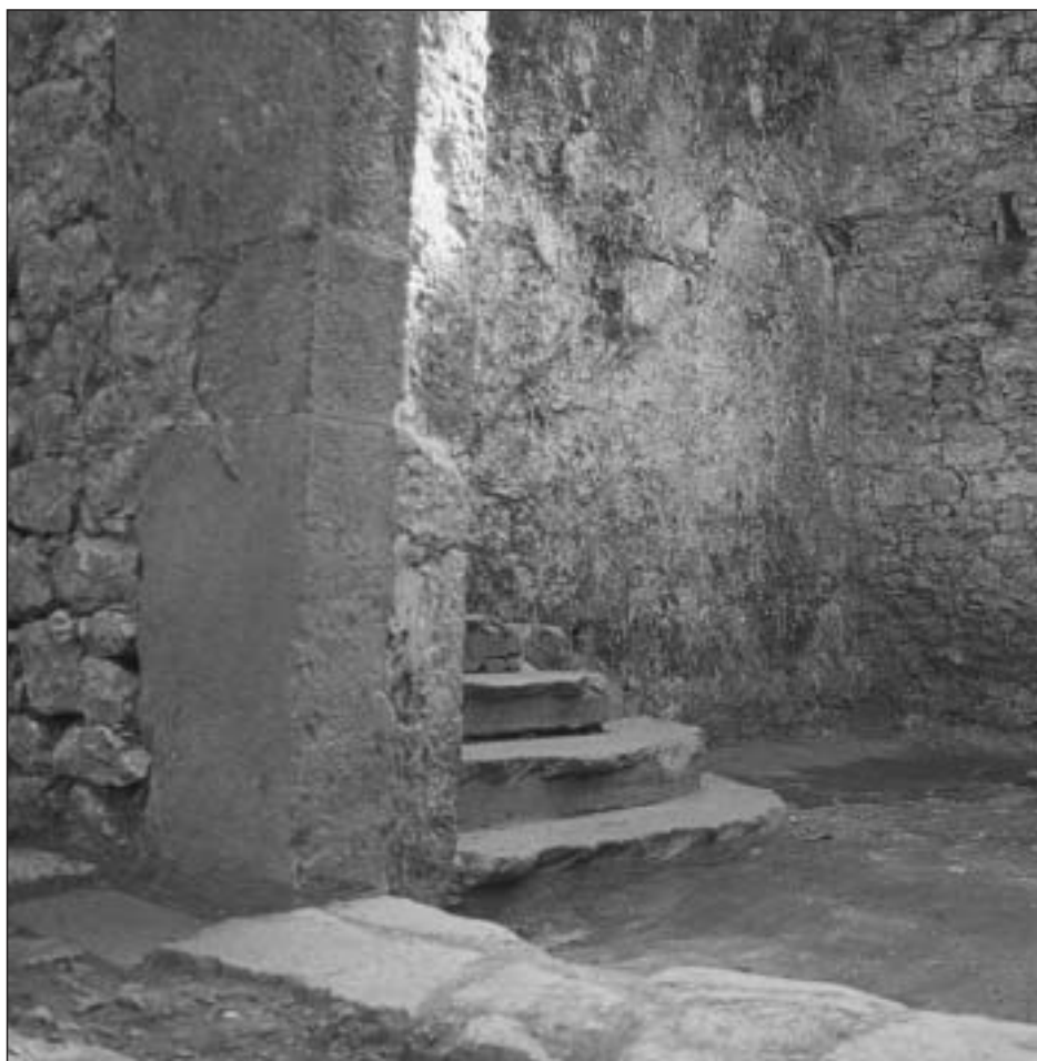
Foto 6. Escaleras de acceso
