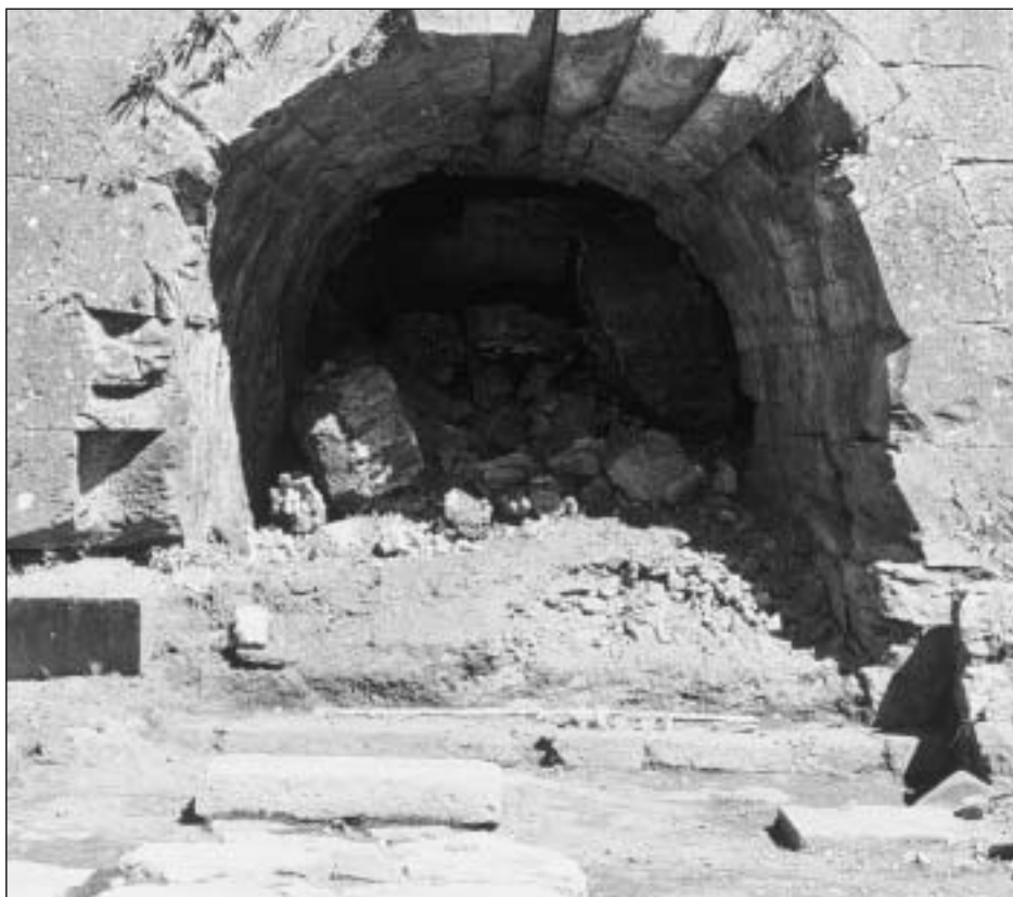
Foto 5. Boca de horno y apoyos de la máquina de viento
