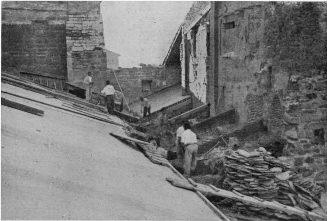
LA OLIVA.— Trabajos de saneamiento en los bóvedas
