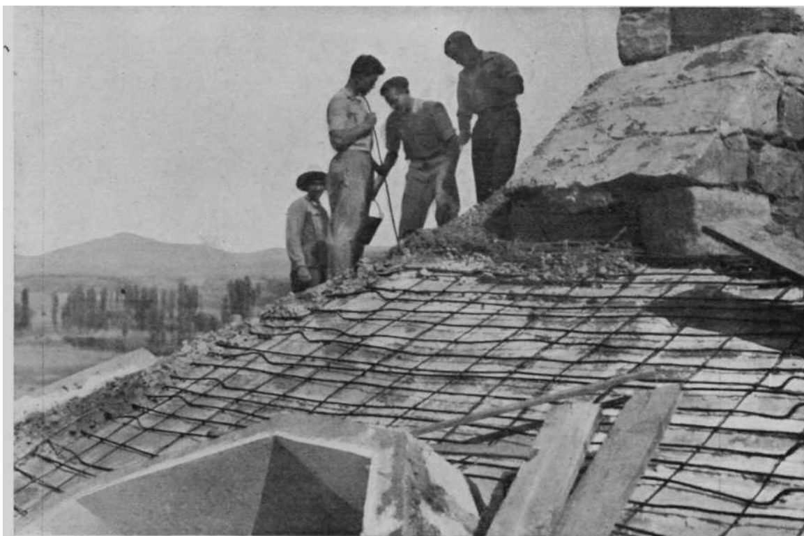
EUNATE.— Hormigonado de cubiertas
