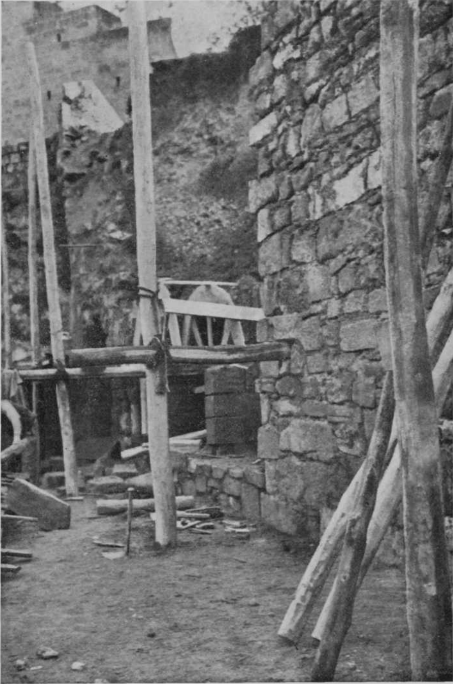
ESTELLA.—Reparaciones en el claustro de San Pedro la Rúa
