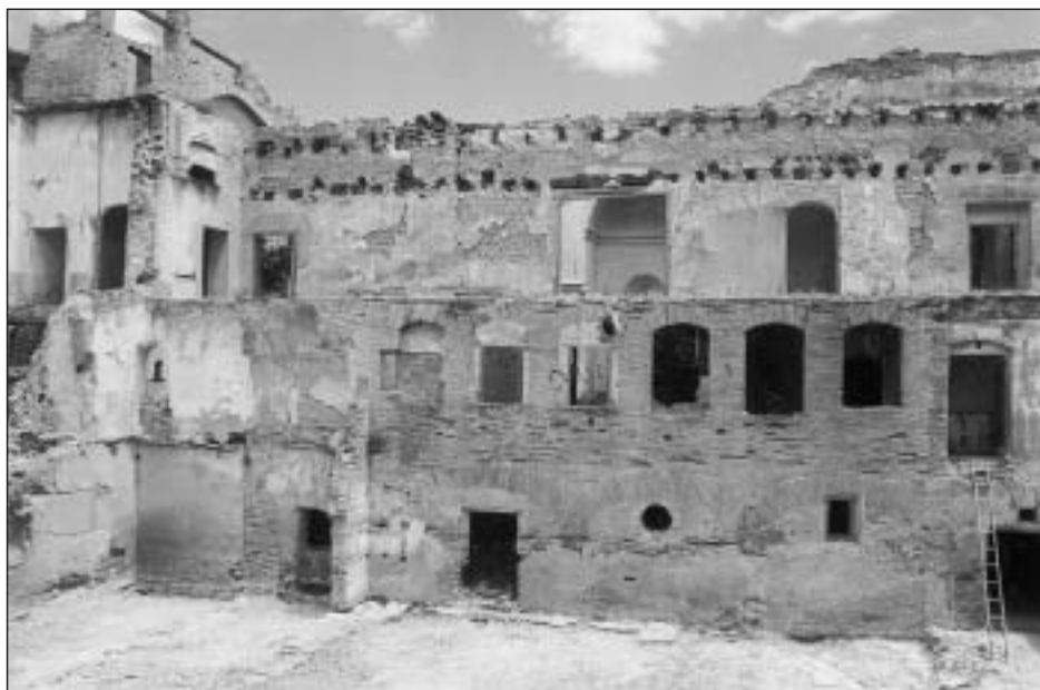
Foto 18. Patio interior, crujía este
