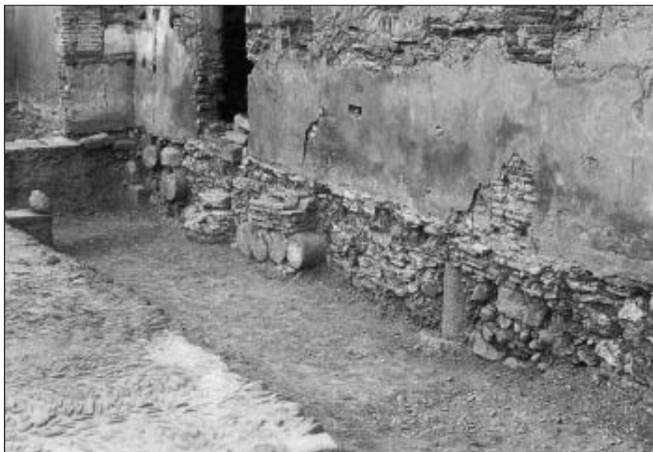
Foto 7. Cimentaciones con elementos reutilizados en el ala este
