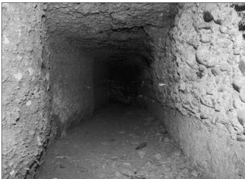
Foto 14. Sistema constructivo de la mina
