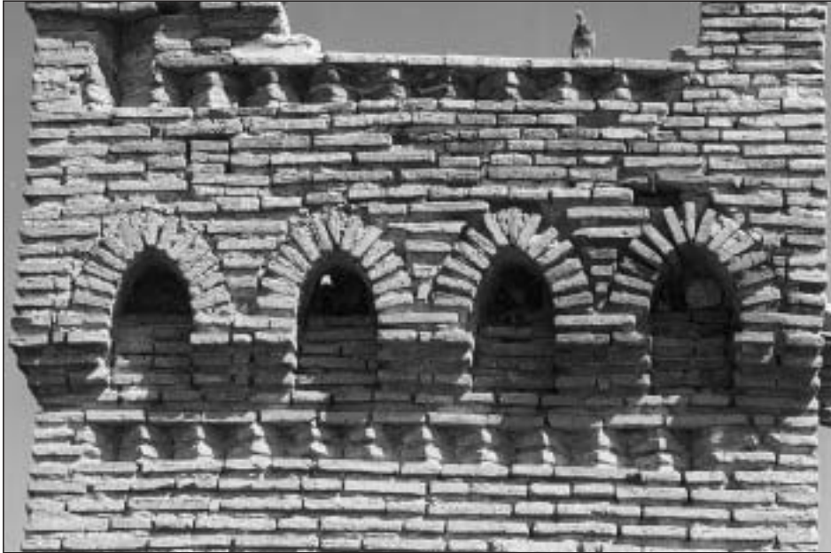
Foto 17. Detalle decorativo del remate de una de las torres
