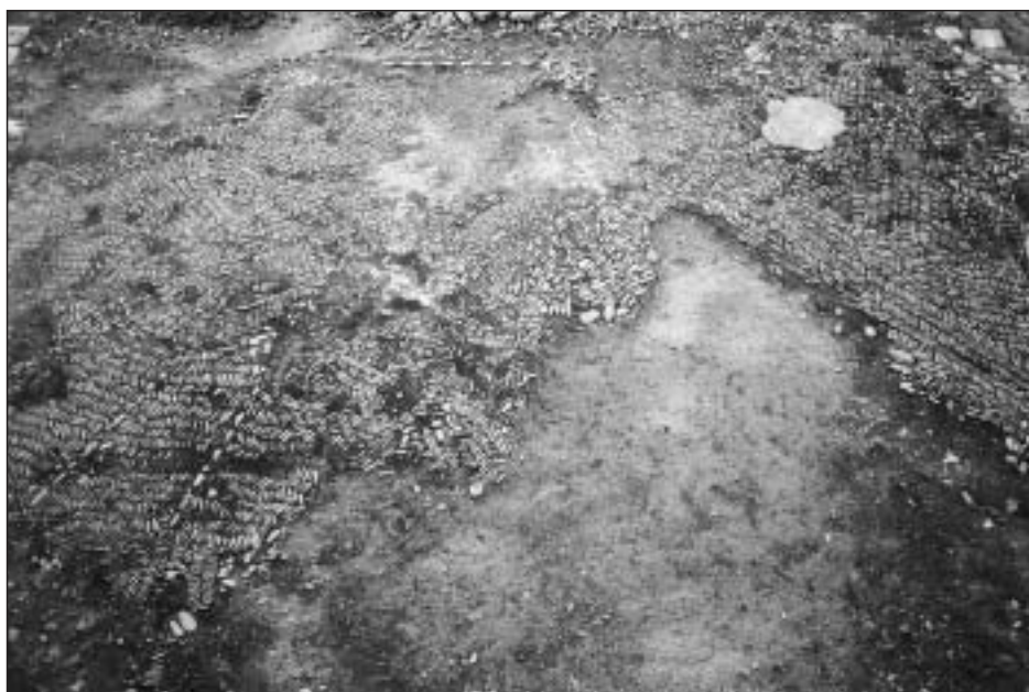
Foto 1. Pavimento del patio central
