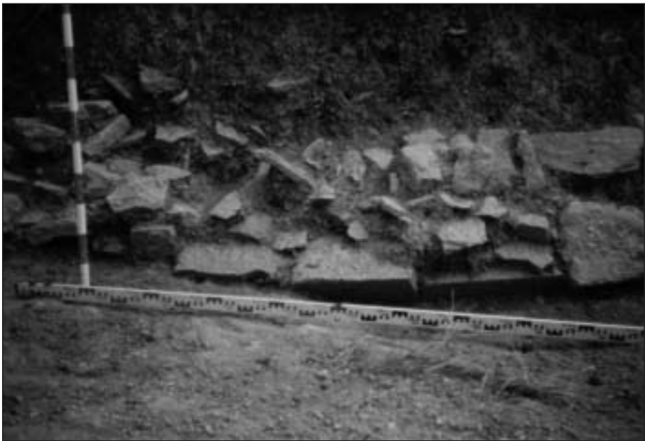
Foto 3. En el Sector 2 el derrumbe es prácticamente total e incluso afecta a la cimentación. Se ve claramente la construcción de la pared a dos caras sobre una cuidada cimentación
