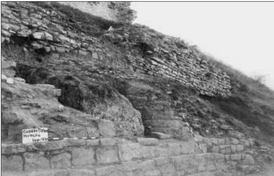
Lámina VI: Visión de conjunto desde el Muro 1, hasta la base escalonada que sustenta los contrafuertes y el relleno de la muralla.
