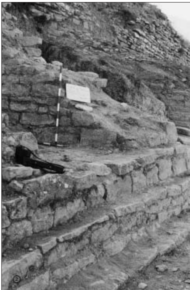
Lámina VII: 1. Detalle de uno de los contrafuertes de la muralla. 2. Asentamiento escalonado, base de los contrafuertes y el relleno.
