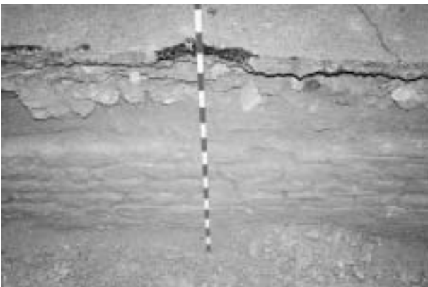
Detalle de la muralla.
