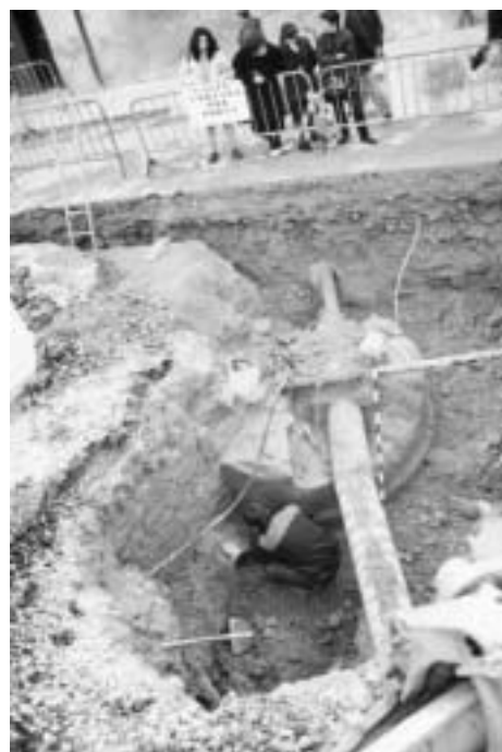
Situación de la escalera y la nueva canalización.
