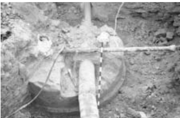
Estructura atravesada por canalizaciones.
