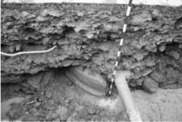
Base de la escalera y canalización.
