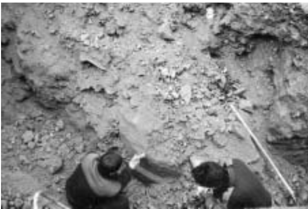
Trabajos de apertura de cata.
