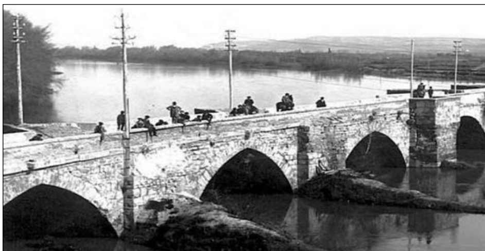
Figura 3. Detalle de los primeros arcos y machones del puente Mayor de Tudela, sin fechar 11 .
