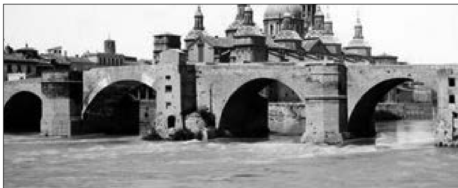
Figura 2. Puente de piedra de Zaragoza, Anselmo Coyne, 1887-1896 9 .
