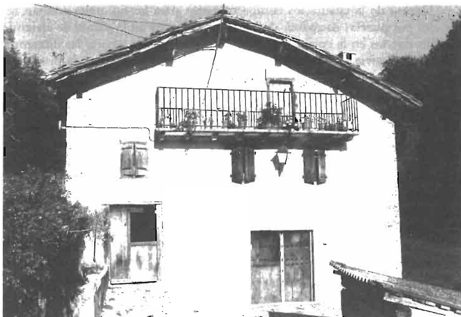
Foto 2: Fachada de una borda o caserío
