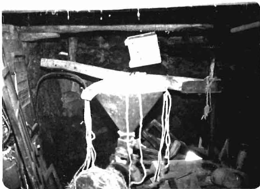
Foto 4.—En primer término el molino triturador de grano. A la derecha, al fondo, la gran rueda del malacate de 1 m. y 100 dientes y encima la pequeña cónica de 20 dientes. A la izquierda, el collarón para sujetar a la mula (en la parte superior una jaula para aves colgando).
