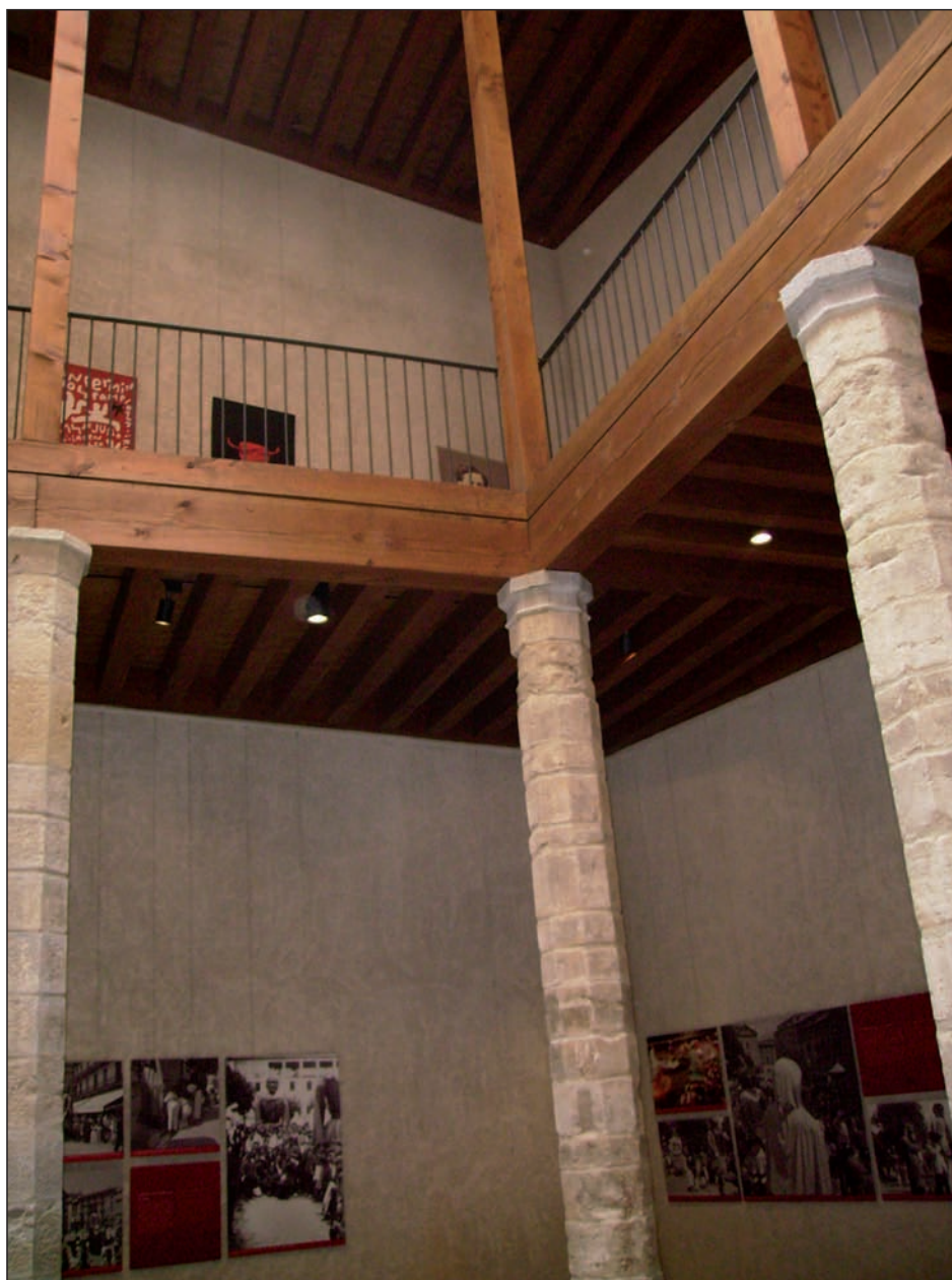
Figura 12. Sabayado nuevo de la planta 0 del patio. Las muestras COND07, COND08 y COND09 se obtuvieron del antiguo. Maderas datadas los años 1517-1518
