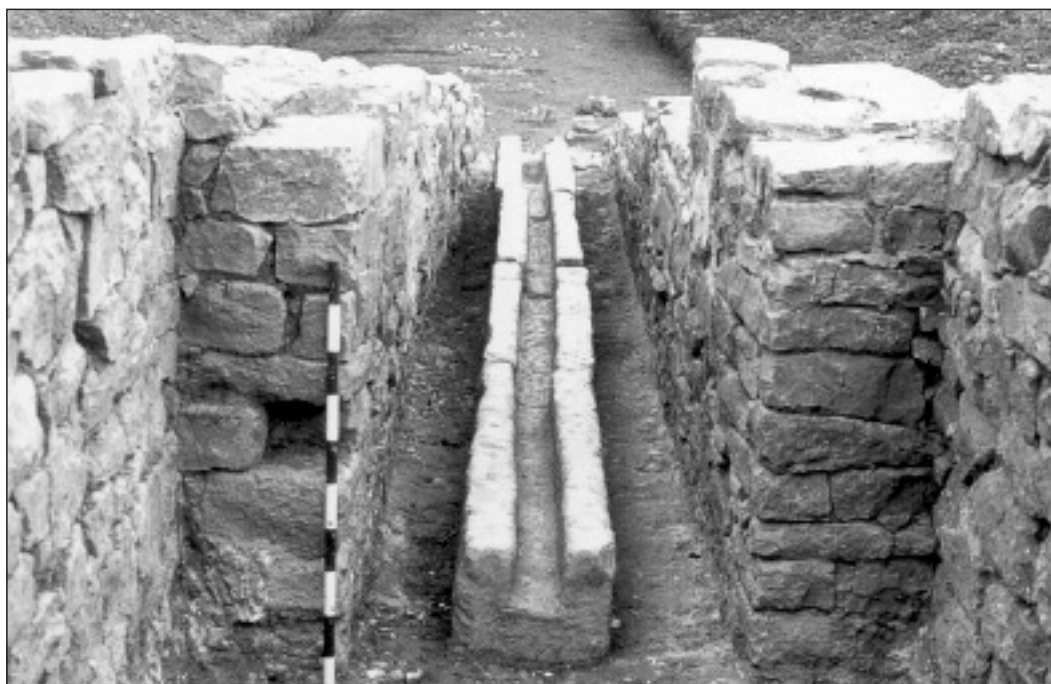
Foto 2. Andelos. Depósito regulador. Salida del acueducto
