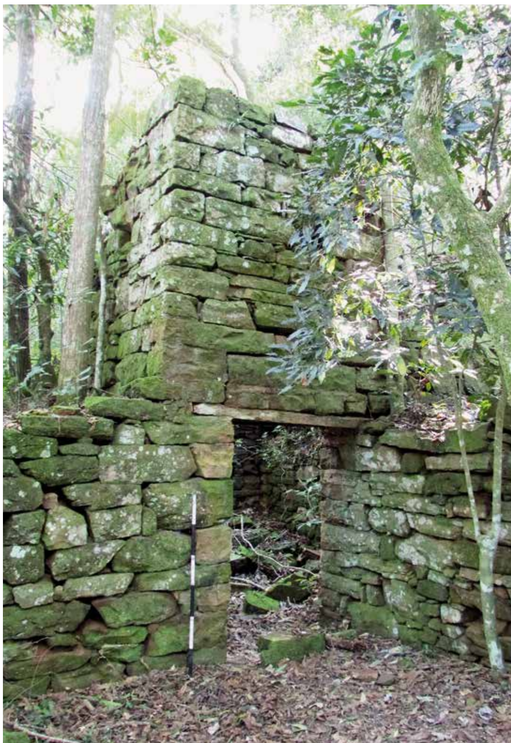
Figura 4. Estructura II de Teyú Cuaré, fragmento de la entrada en pie de los dos pisos, único sector no derruido.
