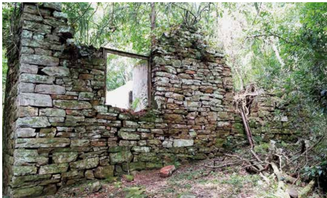
Figura 3. Muro lateral de la Estructura I; nótese el uso de la piedra casi sin tallar y ventanas modernas.
