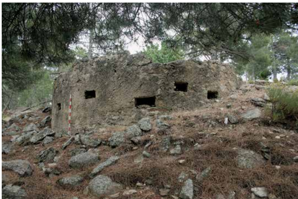
Figura 6. Fortín atípico en la serie del Quinto Regimiento. La disposición de los vanos y otros detalles lo diferencian del modelo descrito en los documentos. Foto: Pablo Schnell Quiertant.
