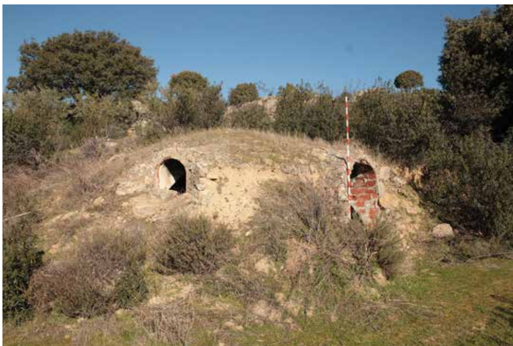
Figura 12. Catenaria lenticular en buen estado que aún conserva su capa de tierra de enmascaramiento. Foto: Pablo Schnell Quiertant.
