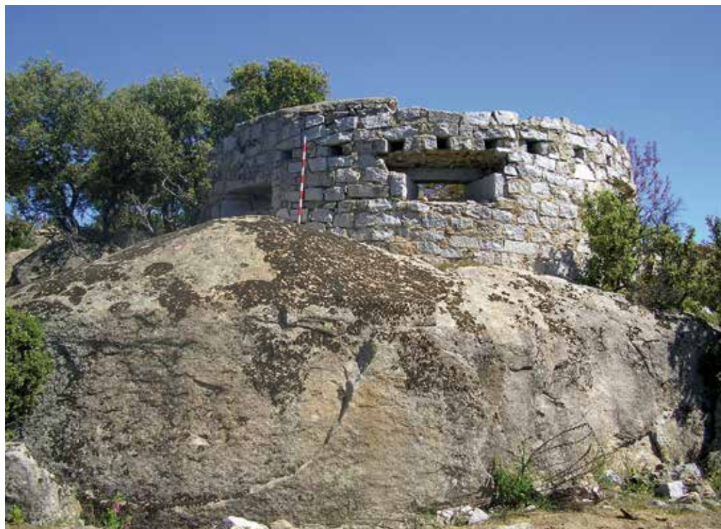
Figura 5. Fortín típico del Quinto Regimiento, con su doble fila de vanos (troneras inferiores para arma automática, aspilleras superiores para fusilería). Se observa el arranque del techo blindado. Foto: Pablo Schnell Quiertant.
