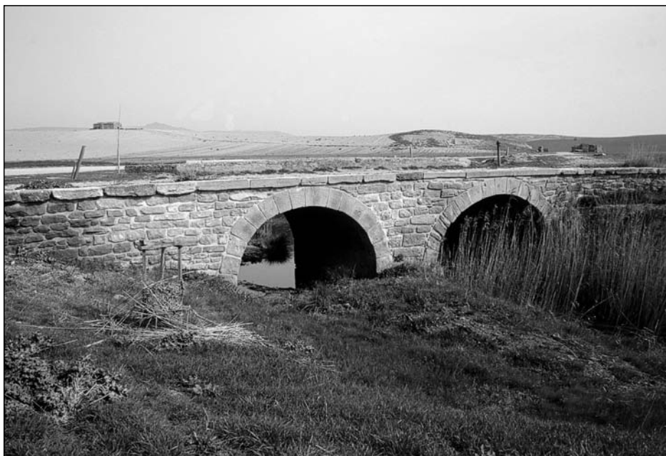
Foto 4. Puente del Prado de San Isidro
