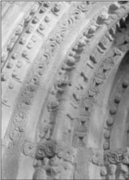
Fig. 7. Detalle de las dovelas 1 a 8
