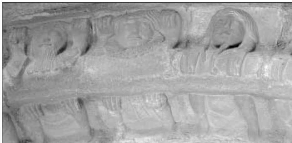
Fig. 30. Detalle de las dovelas 18, 19, 20 y 21
