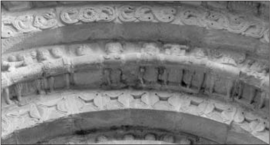
Fig. 6. Detalle de las dovelas 9 a 17
