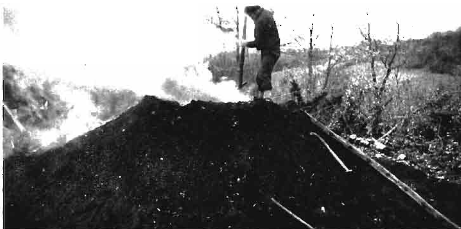
Foto 4.—Urgando en la chimenea.
