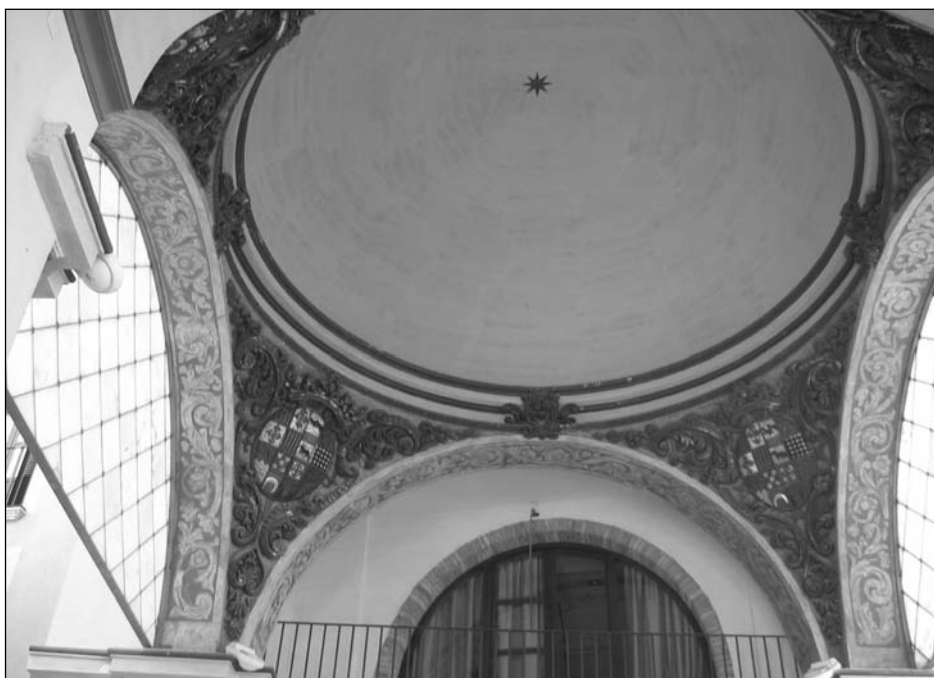
Fig. 20. Antigua bóveda del crucero de la iglesia de San Antón de Tudela
