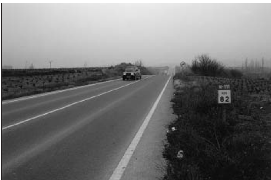
Foto 2: Carretera Nacional 111 a su paso por La Custodia dividiendo el yacimiento en dos mitades.
