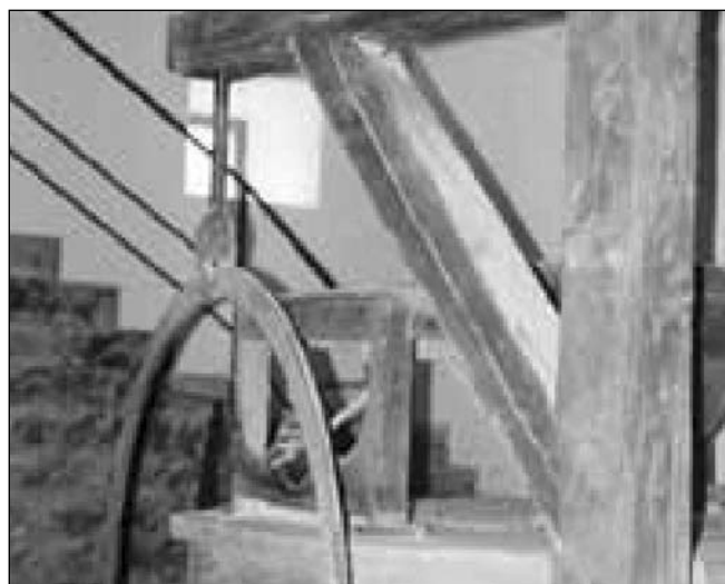
Interior del eco-museo “Molino de Zubieta”. Se aprecia el pescante o grúa elevadora de las muelas para proceder posteriormente a su repicado. Foto: Eco-Museo “Molino de Zubieta”
