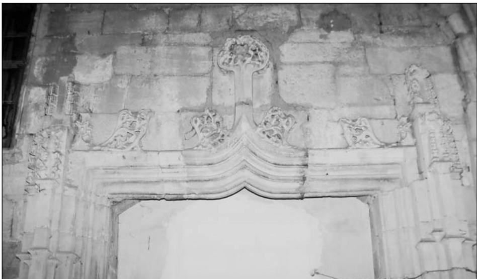
Detalle de la puerta gótica, hacia el oriente, hoy anulada
