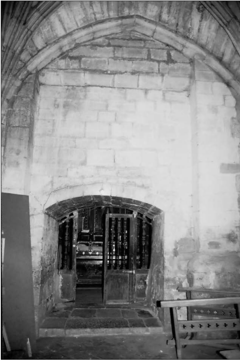
El acceso a la capilla de Santa Isabel, desde el interior de la parroquia, se tiene por un arco rasgado en el hastial románico del poniente
