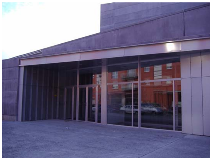
Biblioteca de Pamplona-Mendillorri
