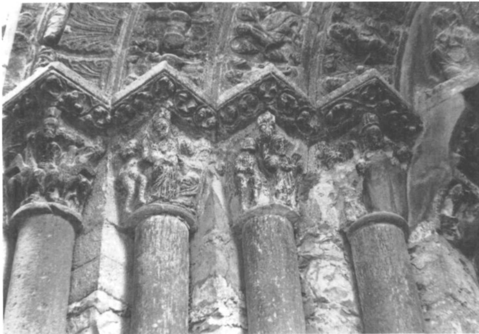
Iglesia de Sta. M. a Magdalena de Tudela. Jambas izdas. de la Puerta oeste.
