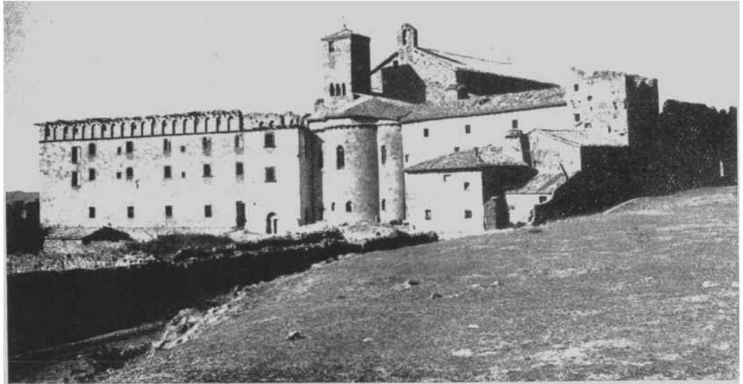
El Monasterio de Leire antes de la restauración.
