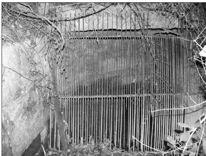
Figura 8. Reja situada al final de la acequia del molino de Mélida
