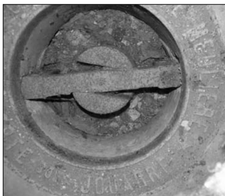
Figura 11. Sistema de anclaje del eje con la piedra volandera. Se observa la tenaza y la lavija
