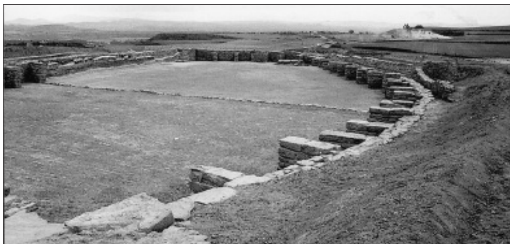
Vista general del depósito-regulador
