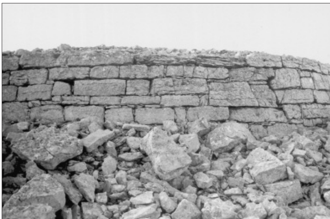
Paramento de la torre
