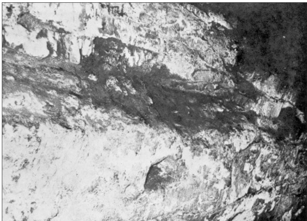
Lámina VII. Pared lateral con huellas del entibado
