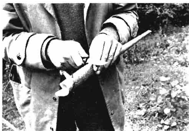
Foto 6.—Con la errena colocada, modo de hacer el primer agujero.
